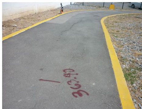
Grieta longitudinal en vitapista, en el cadenamiento del 0+363.40 al 0+369.70.
