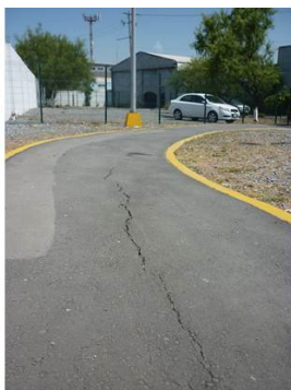
Grieta longitudinal en vitapista, en el cadenamiento del 0+363.40 al 0+369.70.
